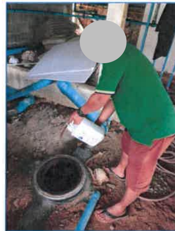
การเติมหัวเชื้อชีวภาพ (EM) ในถังบำบัดน้ำเสีย
