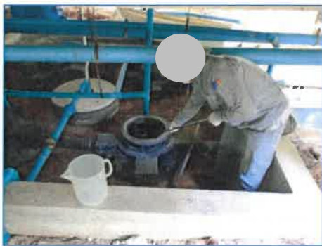
การเติมหัวเชื้อชีวภาพ (EM) ในถังบำบัดน้ำเสีย
