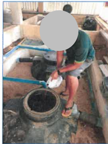
การเติมหัวเชื้อชีวภาพ (EM) ในถังบำบัดน้ำเสีย
